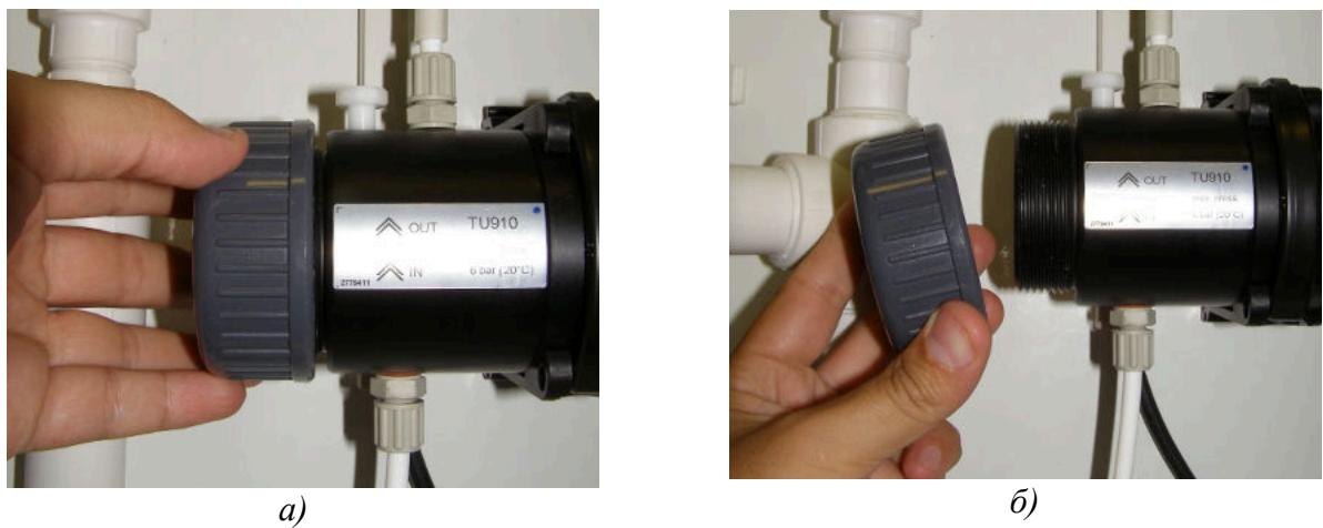
Рисунок 4 - Снятие левой прижимной гайки с заглушкой
